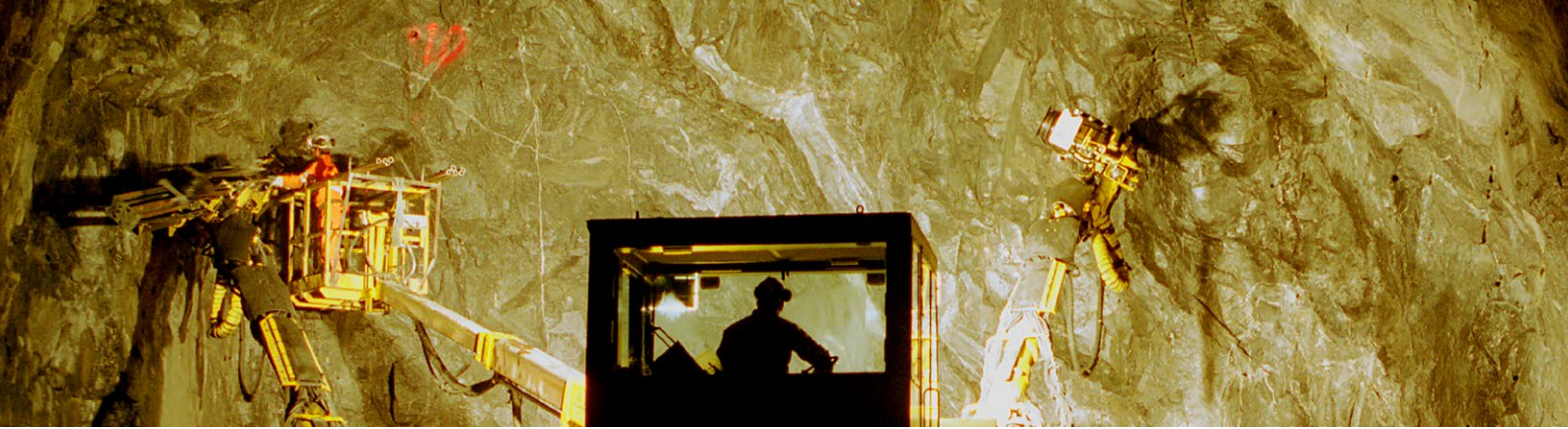
Micro tunkeutuu kallion halkeamiin.
